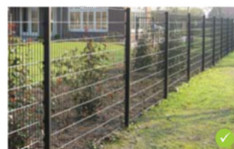
Hekwerk met draadmatten
